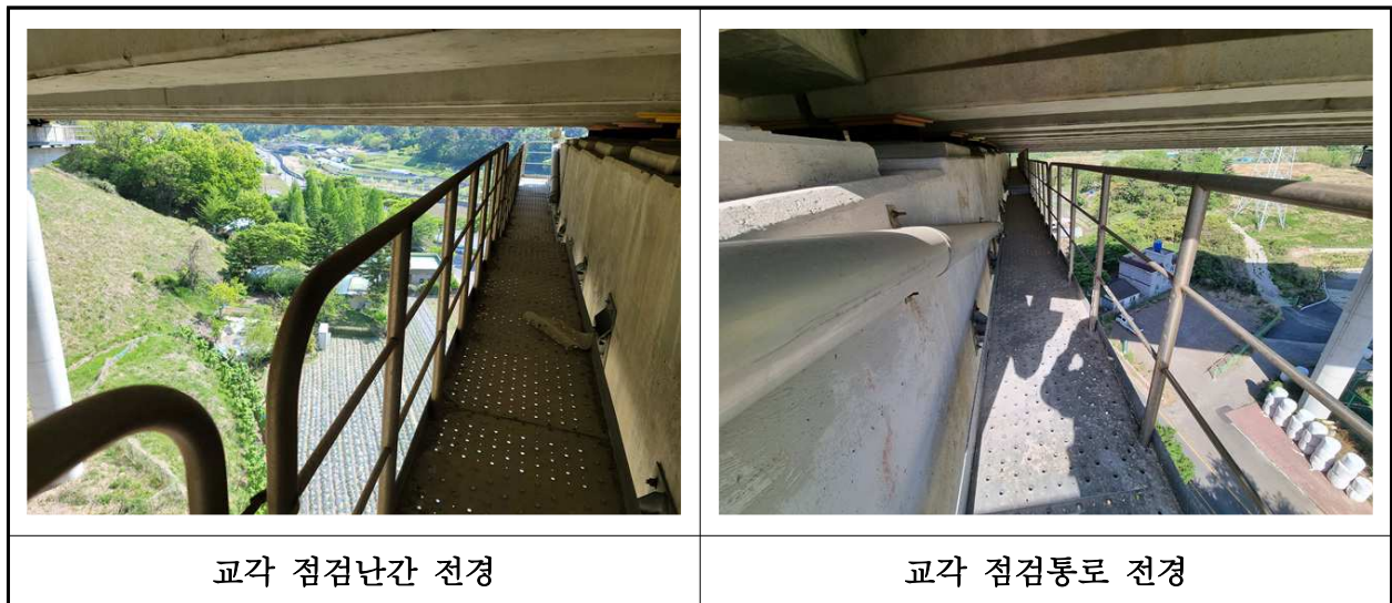
【사진 16.3.26】 교량 점검시설 전경
