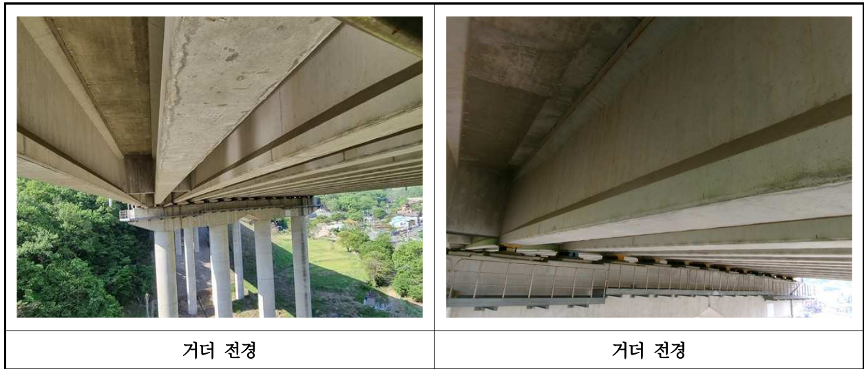
【사진 16.3.4】 거더 전경
