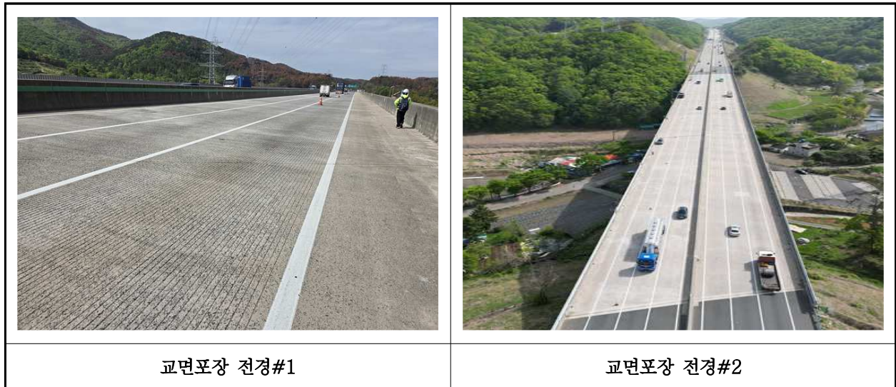
【사진 16.3.20】 교면포장 전경
