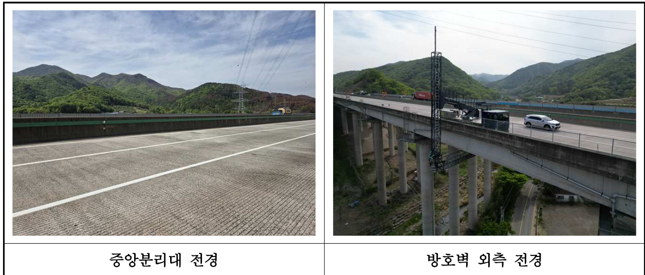
【사진 16.3.24】 방호벽 및 중분대 전경
