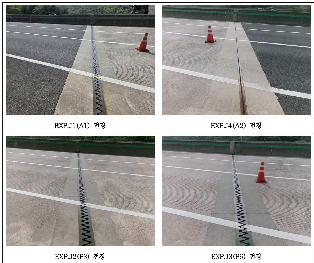
【사진 16.3.17】 신축이음장치 전경
