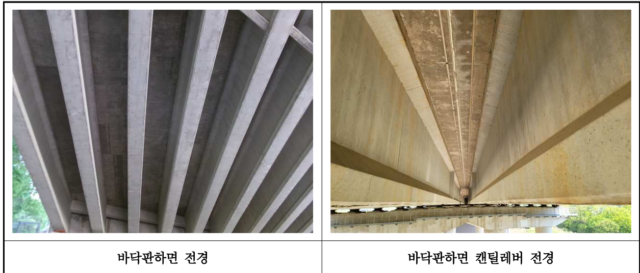
【사진 16.3.2】 바닥판하면 전경
