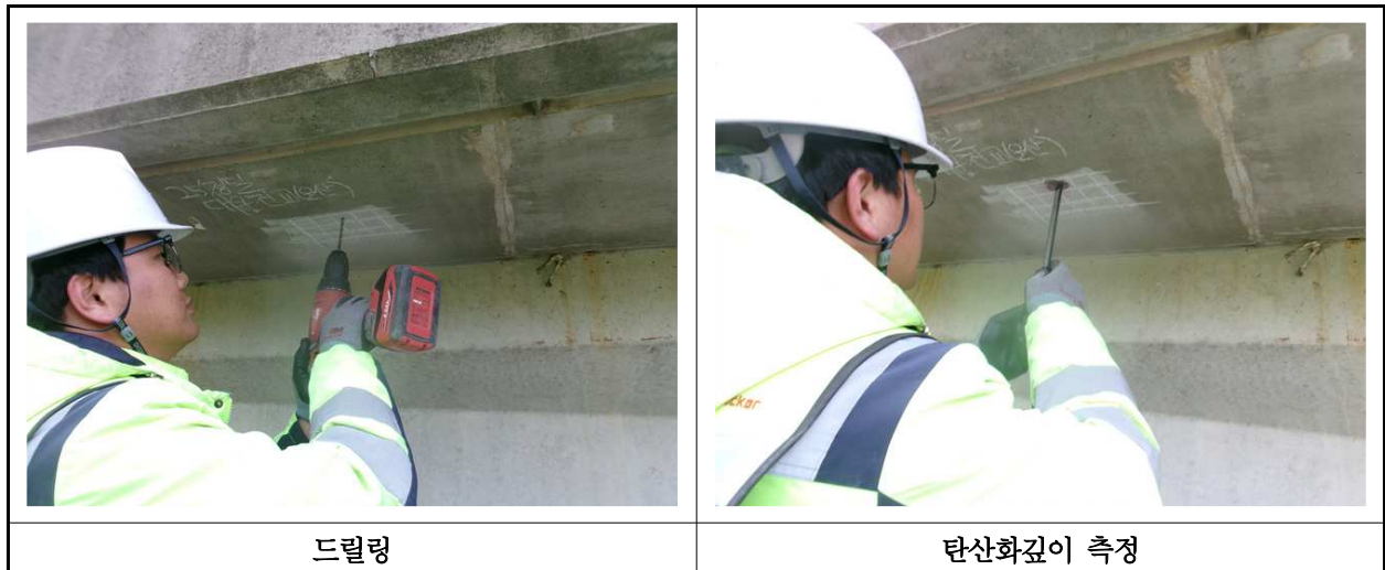
【사진 16.4.3】 탄산화 깊이 측정 현장사진
