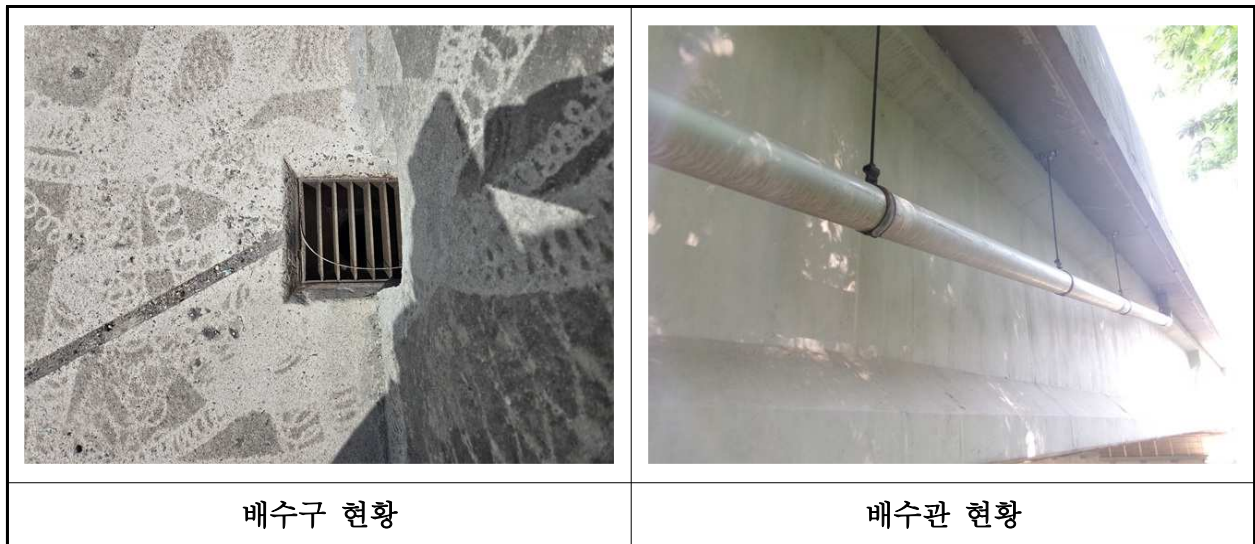
【사진 16.3.22】 배수시설 전경
