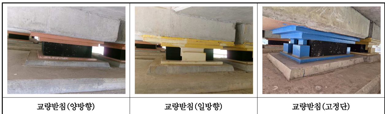
【사진 16.3.13】 교량받침 전경
