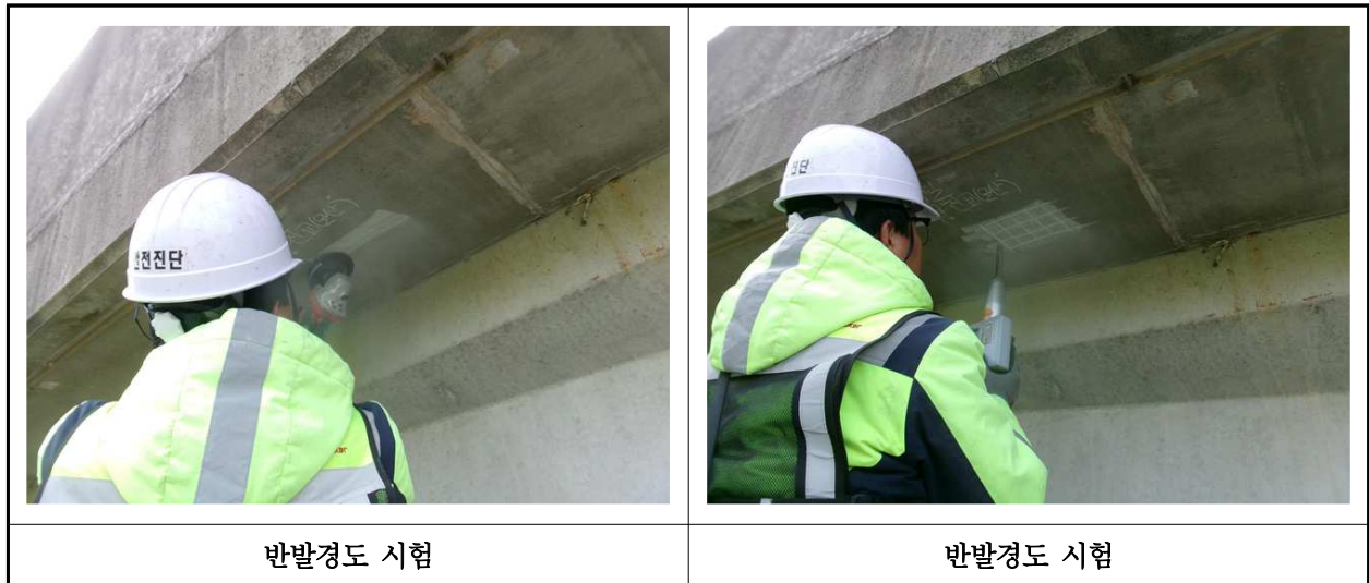
【사진 16.4.2】 반발경도시험 현장사진
