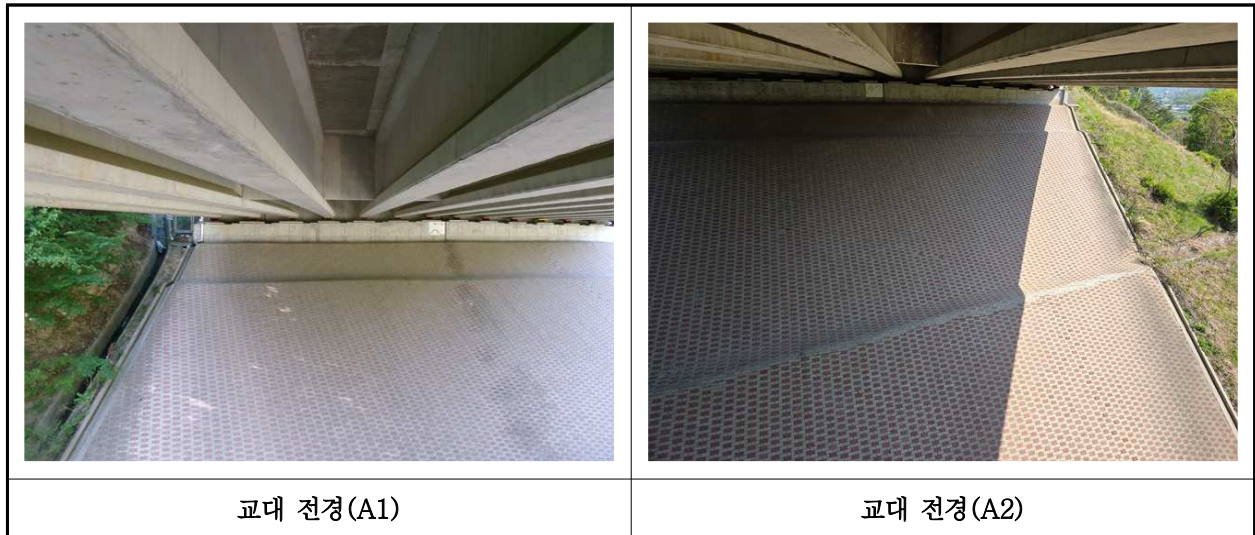
【사진 16.3.8】 교대 전경
